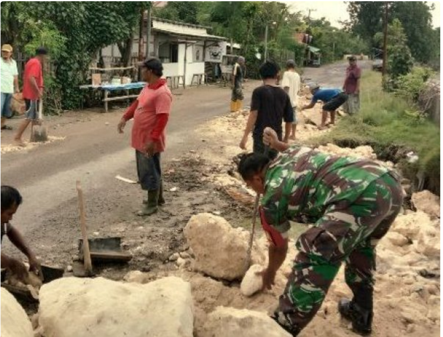
Babinsa Koramil 0829-12/Modung bersama-sama warga memperbaiki jalan yang rusak
